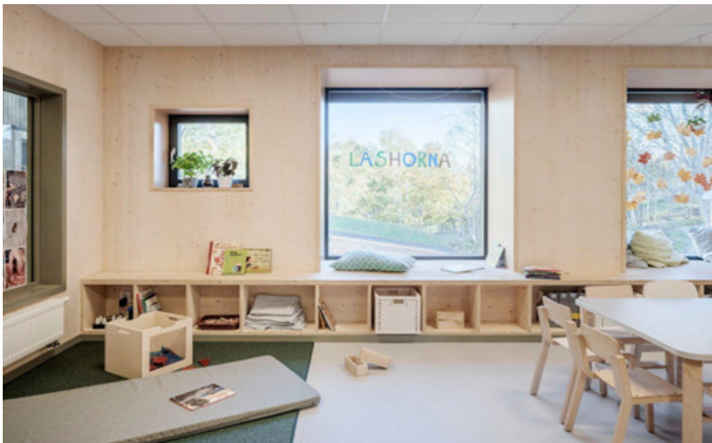
Фиг. 8: Sodra – кръстосано ламиниран дървен материал
